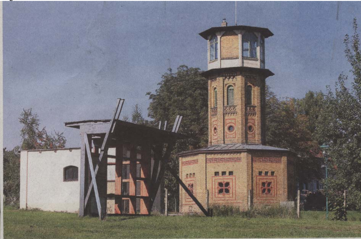
Schmuckstück. In dem Turm von 1890 ist das Märkische Ziegeleimuseum in Glindow untergebracht.
